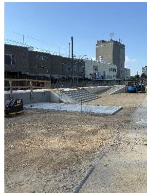
Bau Perronteil Süd
